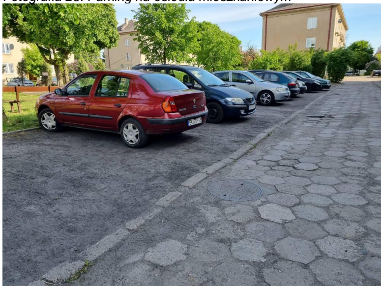
Fotografia 28. Parking na osiedlu mieszkaniowym
