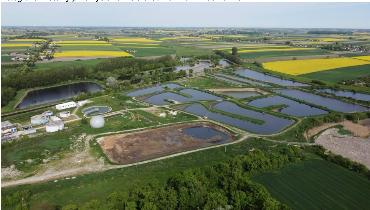
Fotografia 7 Stawy przemysłowe KGS o/Cukrownia w Dobrzelinie
