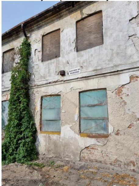
Fotografia 34. Budynek przeznaczony do rozbioru
