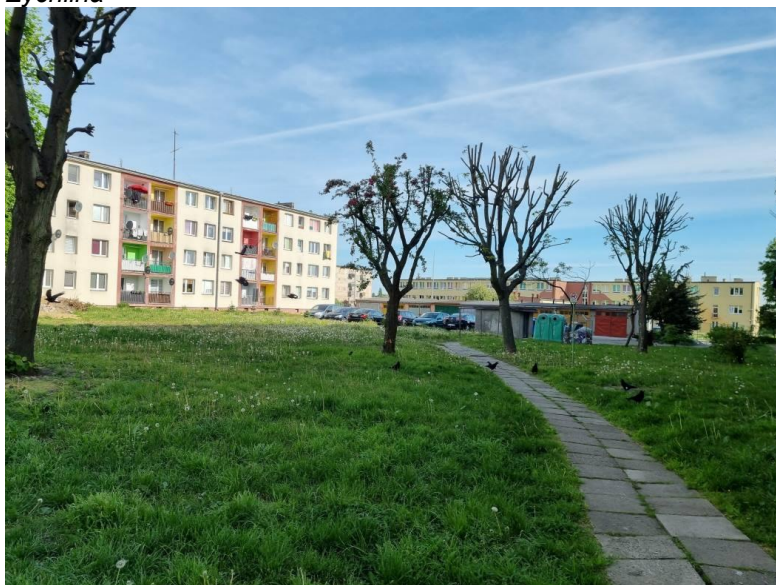
Fotografia 15. Osiedle mieszkaniowe w południowej części Żychlina
