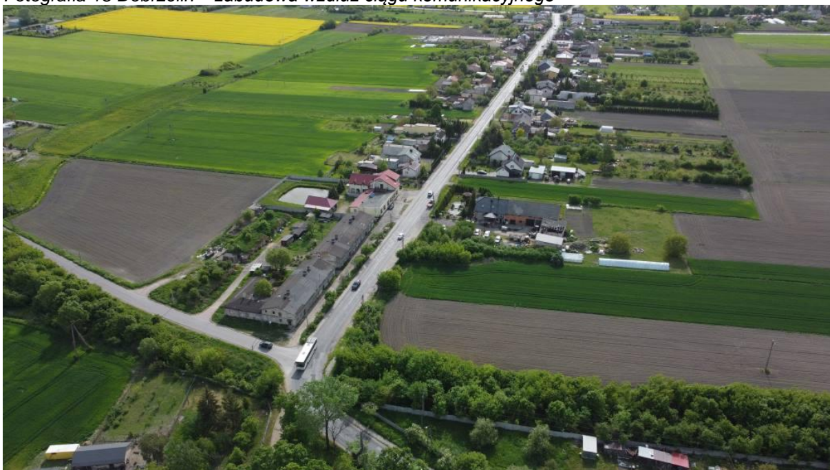
Fotografia 18 Dobrzelin – zabudowa wzdłuż ciągu komunikacyjnego
